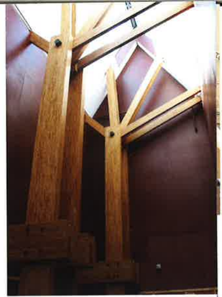
▲ Parallam-palkista valmistettuja kannattinpilareita Kanadan Vancouverissa.
