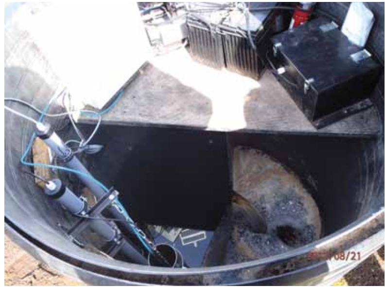
Kuva 5. V-mallinen mittapato ja pato mittakaivossa (kuvat Minna Kukkonen).
