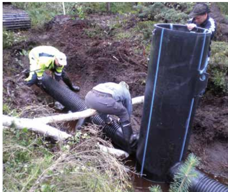
Kuva 2. Vasemmassa kuvassa mittapato sekä vedenlaadun seuranta-asema (kuva Erkki Oksanen) ja mittakaivon asennus oikeassa kuvassa (kuva Leena Finér). Mittalaitteisto asennetaan mittakaivon sisään.
