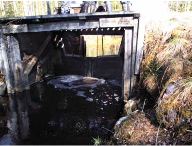
Kuva 5. V-mallinen mittapato ja pato mittakaivossa (kuvat Minna Kukkonen).
